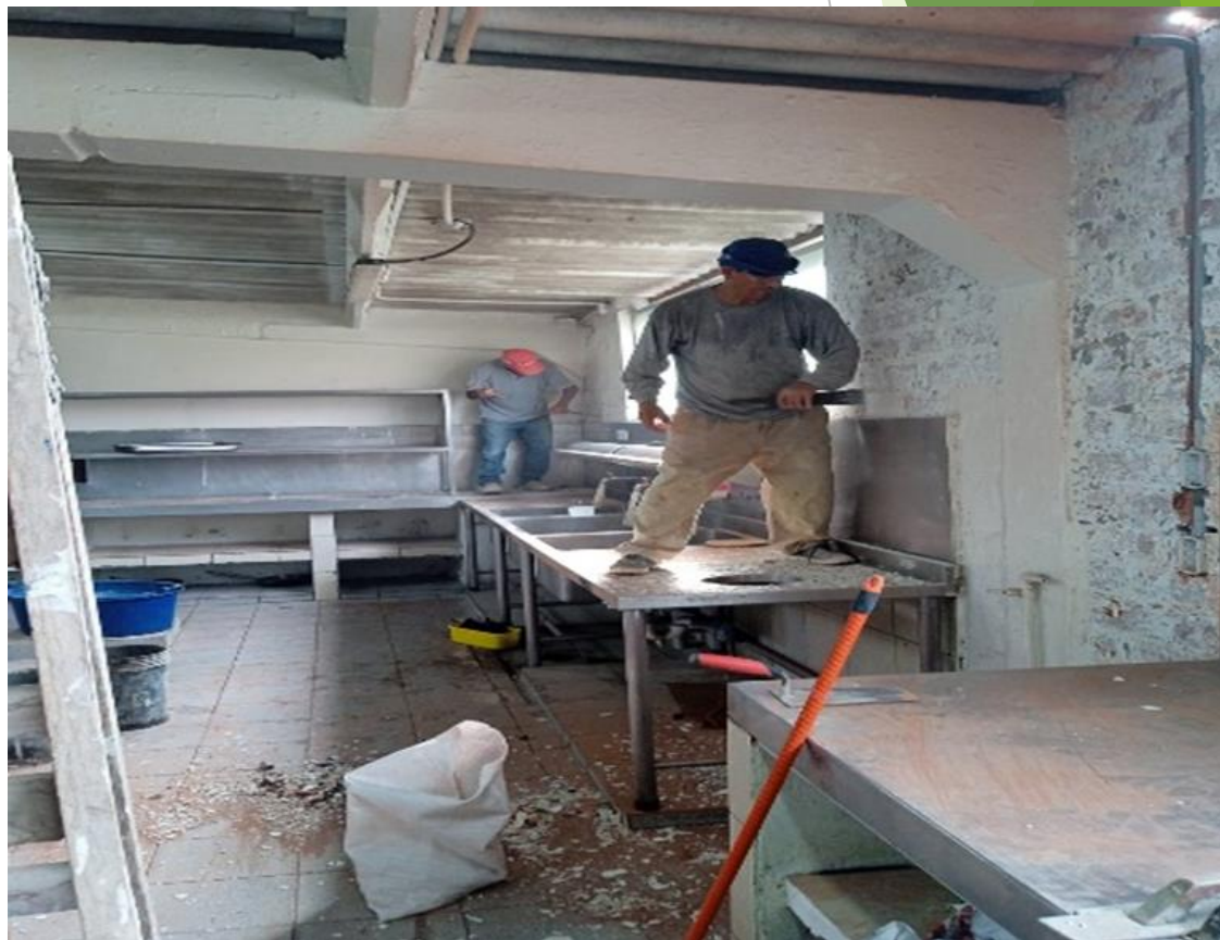
COCINA EN PLENA REMODELACIÓN; ABRIL 2023
